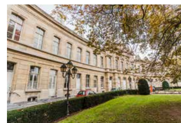
↑ Het Fontainashof, gerenoveerd door de Regie
