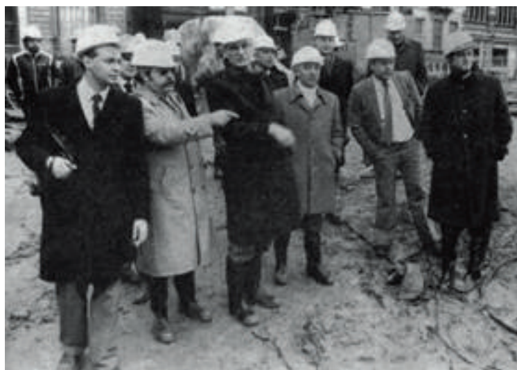
Le Collège communal en visite sur le chantier (coll. ACSG).
