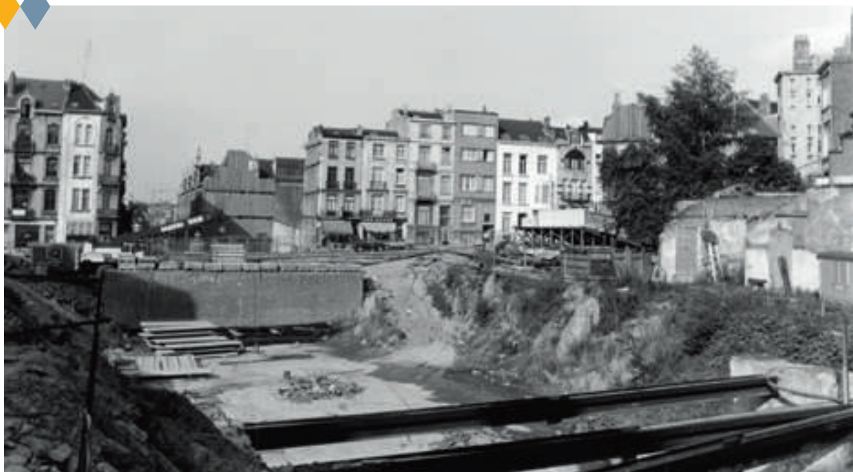
Construction de la station de métro Horta, années 1980 (coll. CHSG).
