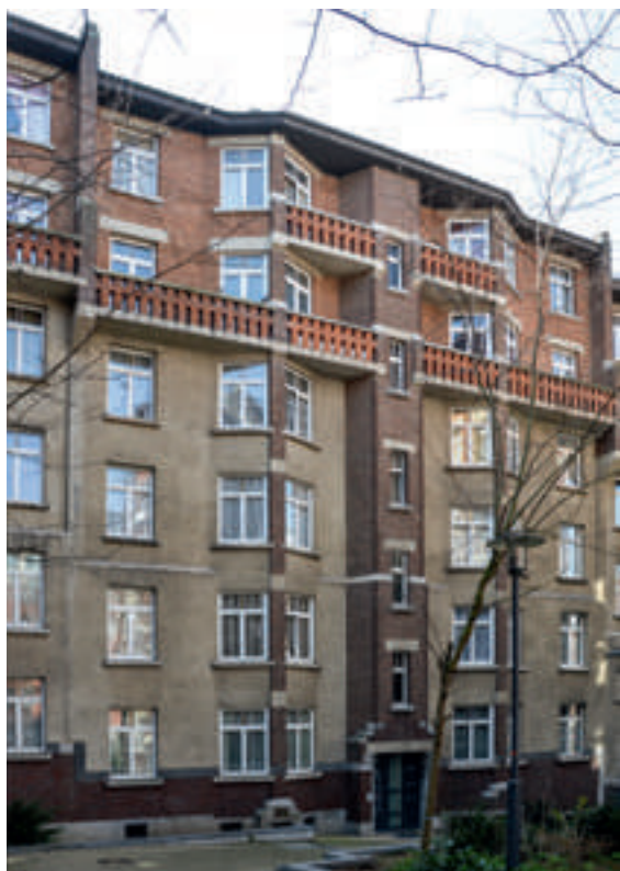
Immeuble du Foyer saint-gillois rue de Bosnie, architecte Joseph Diongre, 1926 © APEB 2015.
