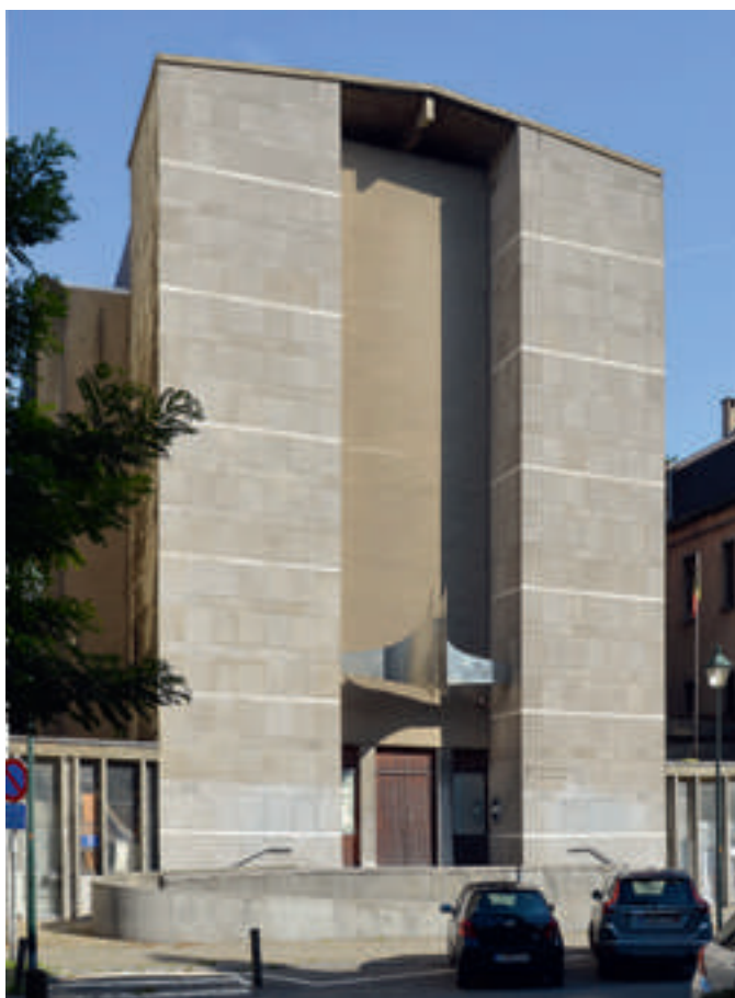
Église Sainte-Alène, avenue des Villas 49-51 © APEB 2015.
