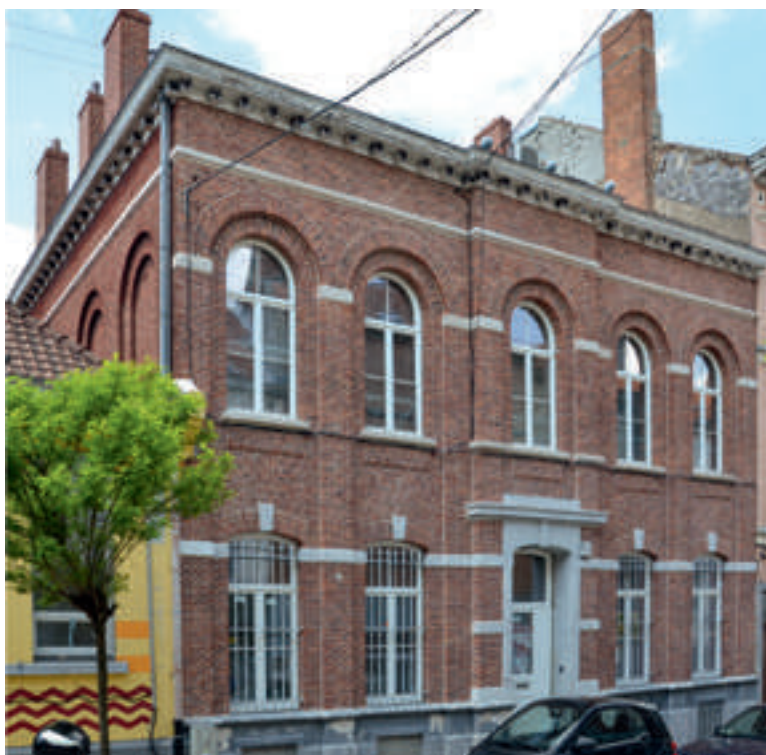
Siège du CAFA, rue du Fort 25 © APEB 2015.
