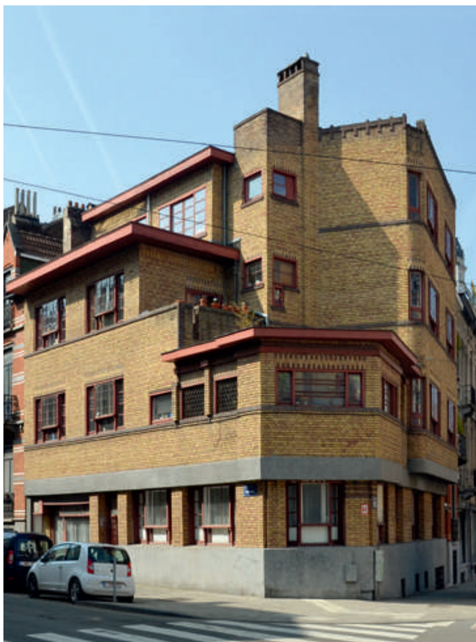
Maison personnelle de Pierre Verbruggen, rue Antoine Bréart 47-49 © APEB 2015.
