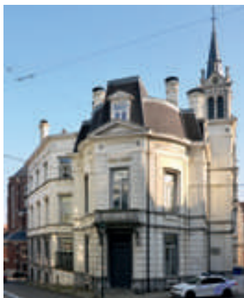
Ancienne maison communale © APEB 2015.
