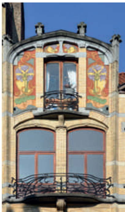
Ensemble d'immeubles Art nouveau rue Vanderschrick, architecte Ernest Blérot © APEB 2015.
