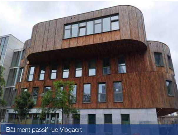
Bâtiment passif rue Vlogaert
